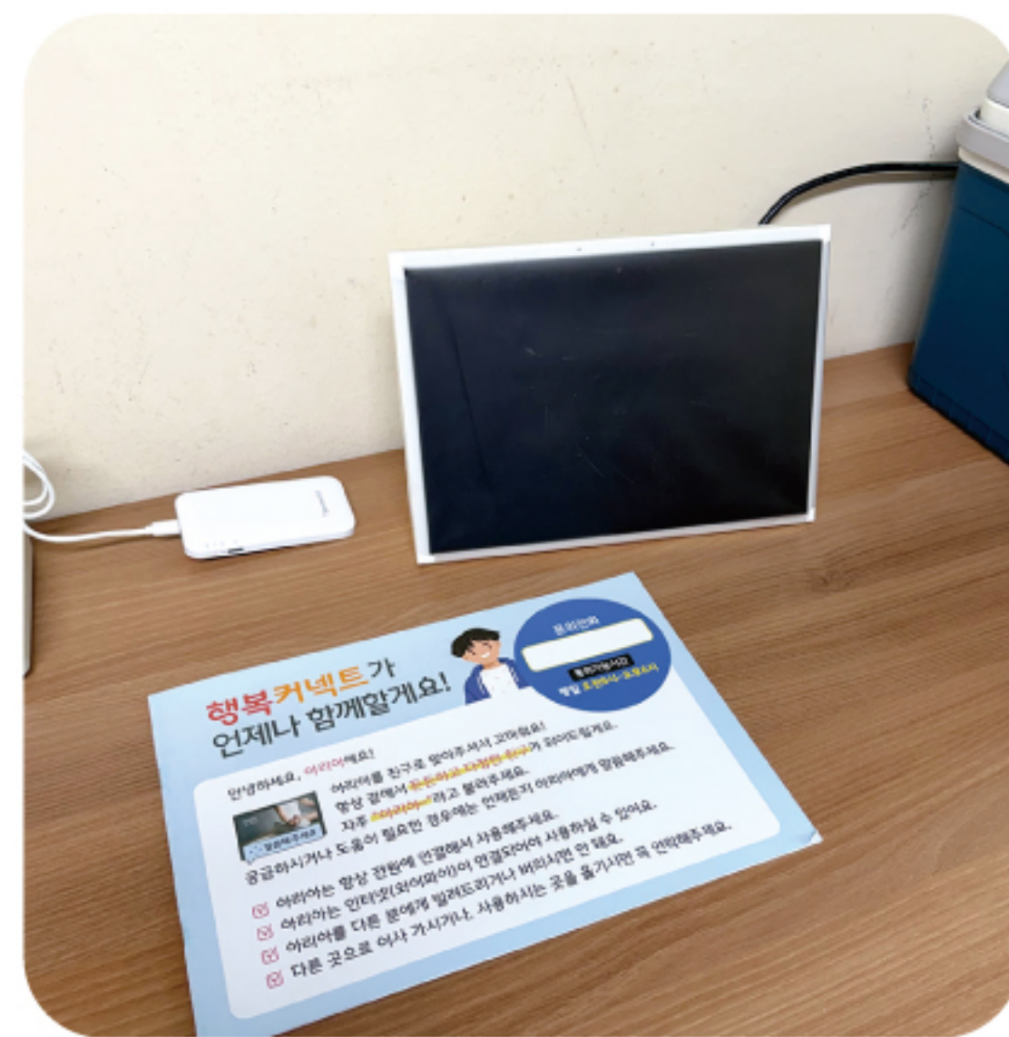
실제 ICT 기기 설치 모습
